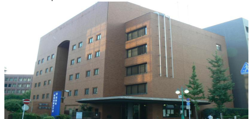
福岡県福岡東総合庁舎
